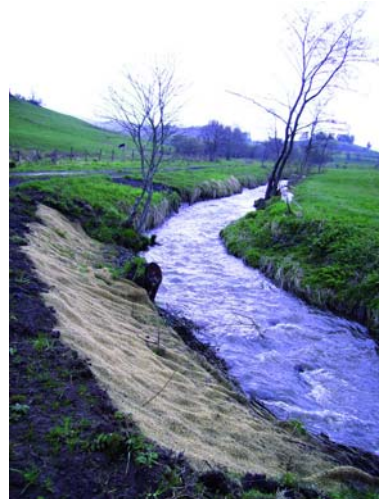
Restauration de berges par techniques végétales (fascines en pied de berge et bouturage)
